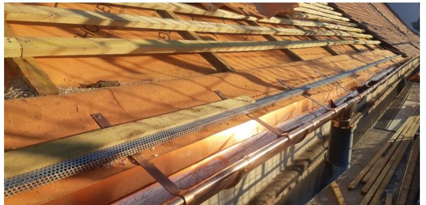
Après remplacement des anciennes gouttières
