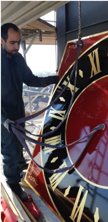
Remontée des cadrans restaurés en haut du clocher avec une poulie
